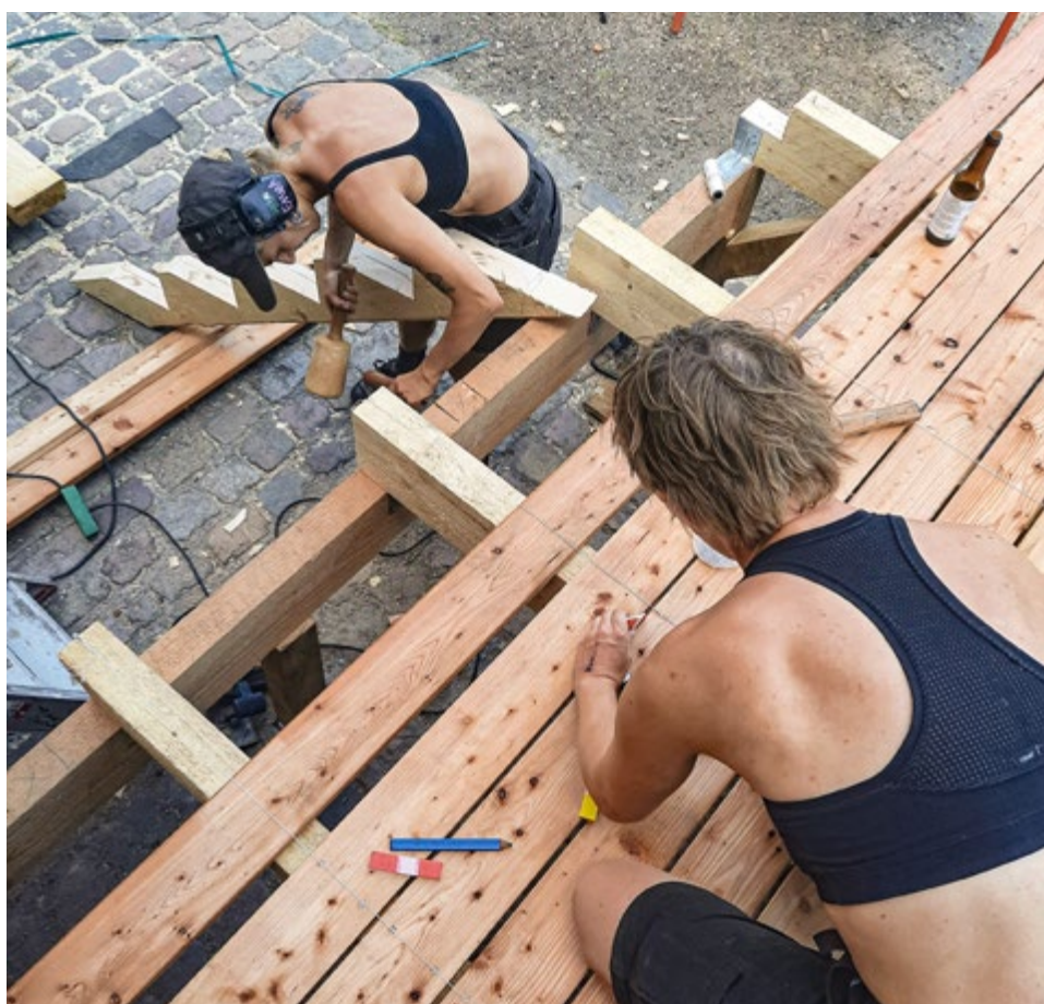
Bygningsnedker Emma Lyhn Støvring stemmer ud til trappens vanger, mens møbelsnedker Laura Klakk mærker op til skrue på terrassedækket.
